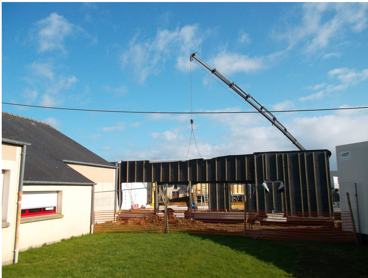
Photo des travaux
